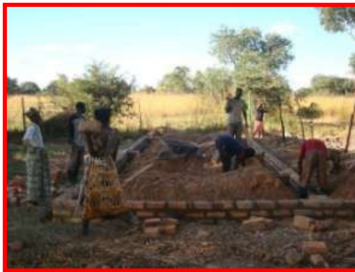
Die bouwerk op die perseel gaan voort The building work on site continues
